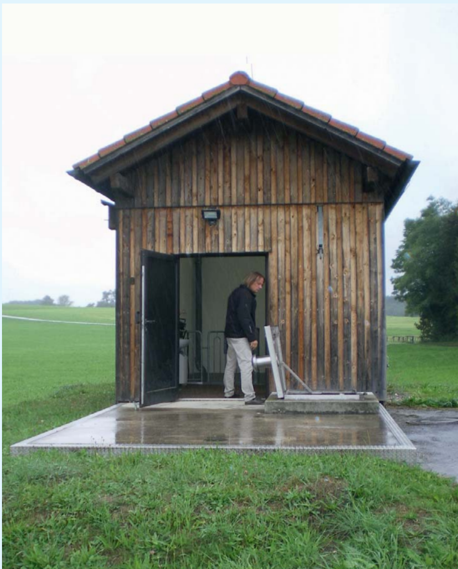
Bild 4 Ansicht der Pumpstation DZ04 der Ammerseewerke
