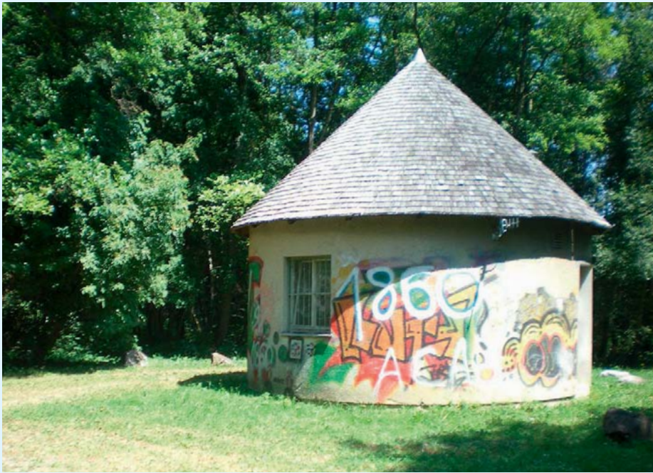
Bild 3 Graffiti-beschriftete Pumpstation Riederau – kein Grund für eine Sanierung
