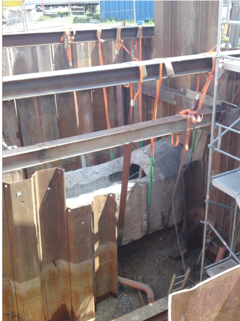
Abbildung 3: Umpundete Baugrube mit „aufgehängtem“ Kanal des Bestands. Zur Vermeidung einer kostenintensiven Abwasserhaltung wird um diesen Kanal betoniert.
