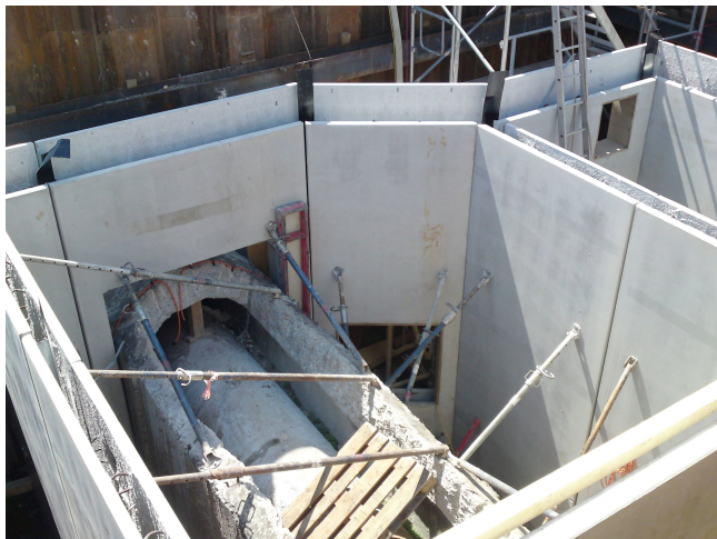
Abbildung 4: Erstellung eines neuen Abwasserentnahmeschachs für die Bypass-Wärmetauscheranlage im laufenden Betrieb des bestehenden Abwasserkanals.
